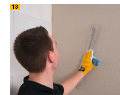
Glätten des Multipor Leicht- und Armierungsmörtels
