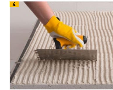
Wichtig ist der vollflächige Auftrag des Multipor Leichtmörtels quer zur Ansetzrichtung
