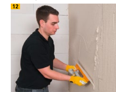
Abziehen der Armierungsschicht
