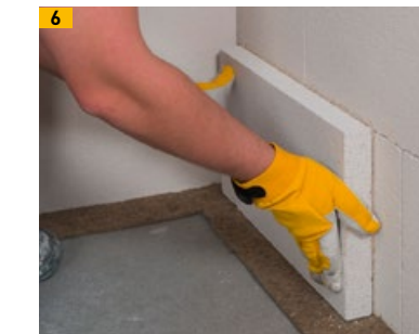
Multipor WI compact plus nach dem Andrücken 2 bis 3 cm verschieben, sodass die Stege umklappen und eine vollflächige Verklebung gewährleistet ist
