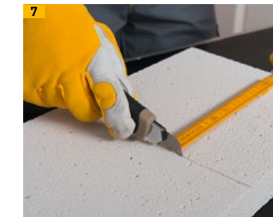
Passstücke können einfach mit einem Teppichmesser angerissen und geschnitten werden
