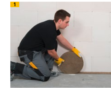
Zur Entkopplung wird der Multipor Hanf Filz dämmstreifen auf dem Boden ausgerollt
