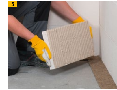
Platte mit den Stegen quer zur Schieberrichtung ansetzen und andrücken
