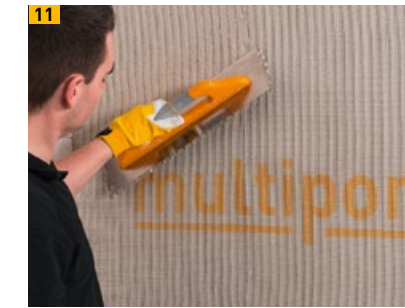
Multipor Gewebe als Armierungslage einbetten
