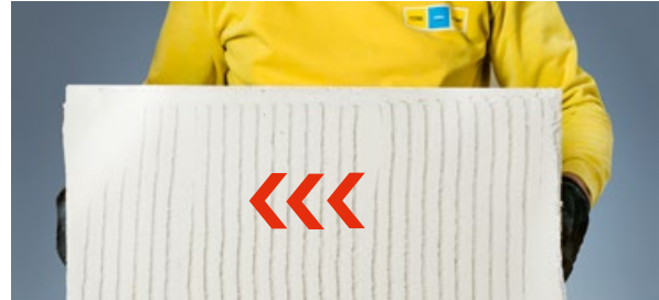
Stege mittels Einschwimmen verwischen...
