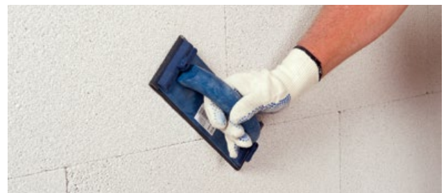
Beschleifen von Unebenheiten
