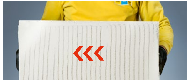
Stege mittels Einschwimmen verwischen...
